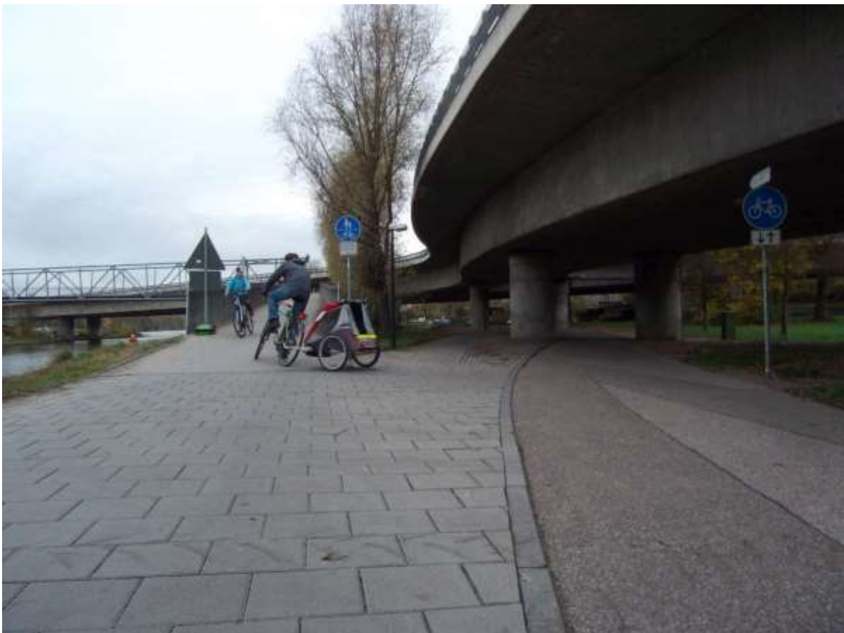
Nördliche Auffahrt zum Fuß- und Radfahrersteg Pfaffenstein: Hier ist es oft eng und unübersichtlich (Foto: ADFC)
